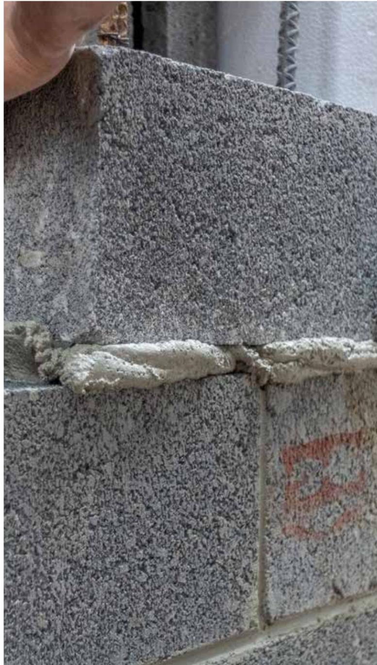
Pueden ser utilizados para muros o tabiques de cerramiento y de forma estructural en muros de carga. Los bloques de concreto vibro compactados son aptos para todo tipo de mampostería, este producto ha alcanzado un alto desarrollo a nivel mundial, justificado por sus ventajas constructivas y su gran versatilidad de usos en viviendas, edificios, diversidad de muros, cierres de naves industriales y otros.
